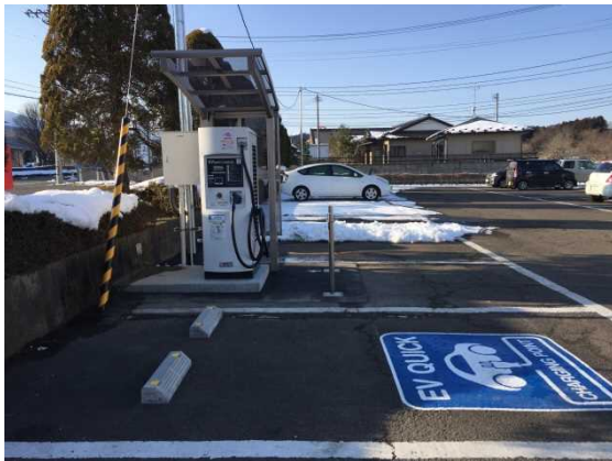
当社製電気自動車用充電器 SDQC-30-U-CS 設置の風景
