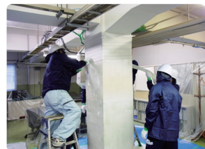
包帯工法による耐震補強の風景 (新電元工業)
