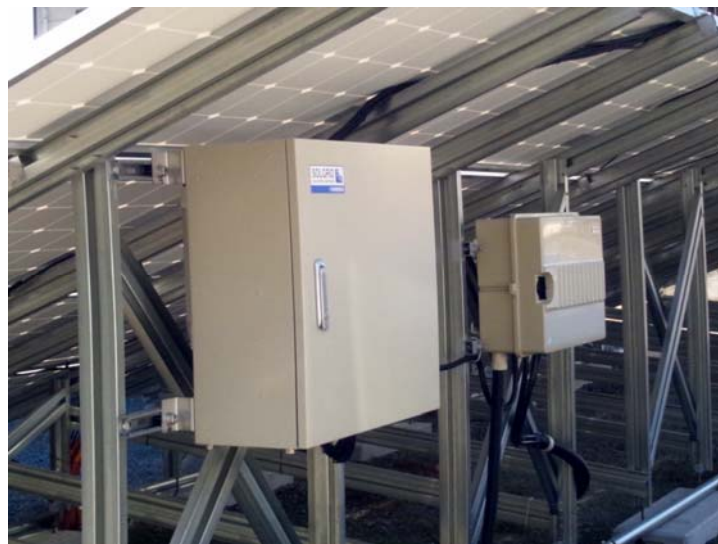
当社の太陽光発電用パワーコンディショナ SOLGRID ® SERIES(写真左)
