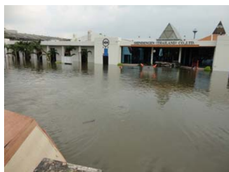
新電元タイランド・工場の浸水時の状況
