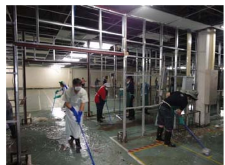
工場建屋内の清掃時の様子
