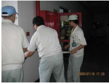
【消防設備の定期点検】 広州新電元
