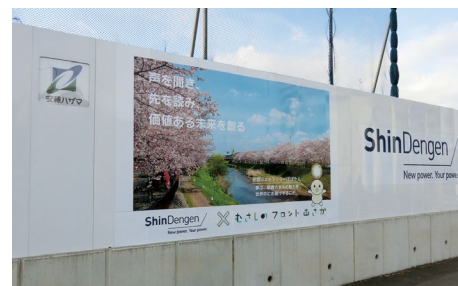
工事現場囲いフェンスのポスター
